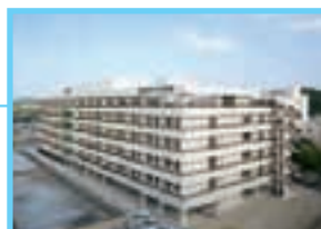
平成19年 D病棟竣工
