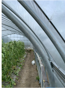
(写真7) ハウス骨組み
