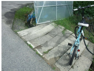
(写真10) 割れたコンクリート橋
