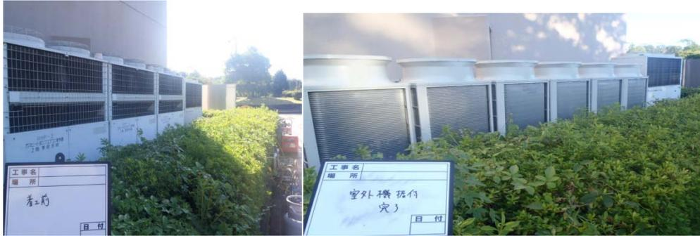
本部管理棟空調設備ガスヒートポンプから高効率電気式エアコンに更新
