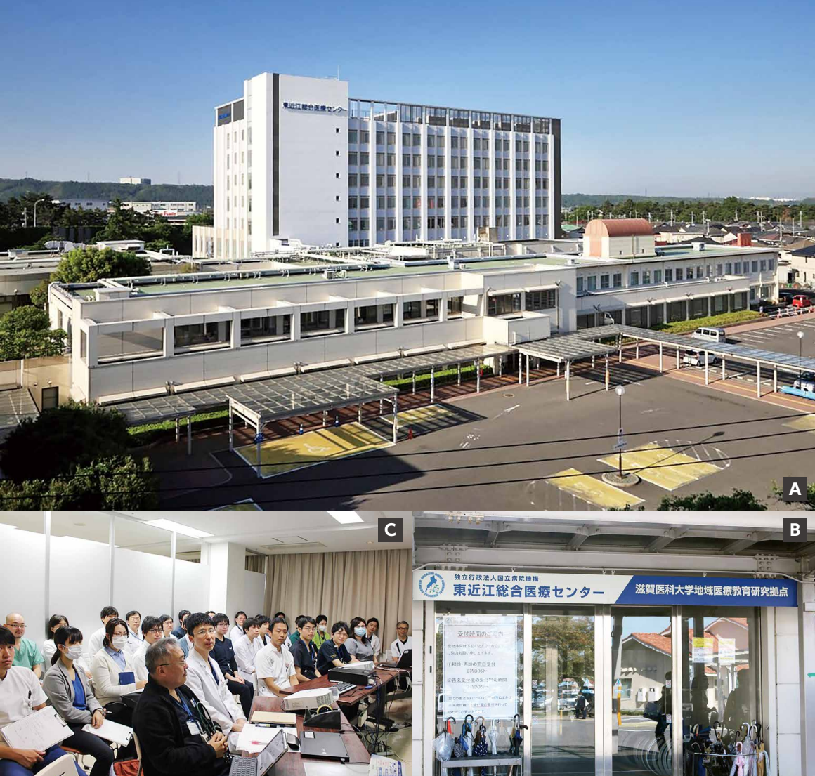
A 外来棟（手前）と奥の新病棟完成後 B 外来玄関の滋賀医科大学関連施設の表示 C 朝の総合内科カンファレンス風景
