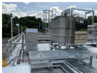
【中和処理ユニット】
