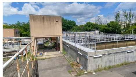
【外観：改修工事後】
