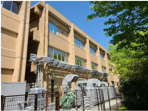
東面外観状況
