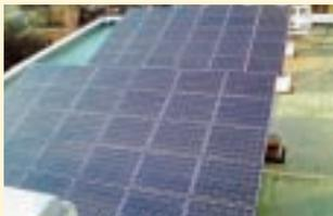
基礎実習棟の屋上に、最大7.5Kwの太陽光発電システムが増設されました。設置された太陽光発電パネルは合計60枚、面積約80㎡で、発電量は一般家庭の使用電力の3戸程度。昨年度設置した最大2.5Kwの太陽光発電システムとあわせて、合計10Kwの設備が完成しました。発電された電力は学内で使用する電力の一部に充てられます。本学では今後も施設面での地球環境保全に関する取り組みを進めていく予定です。
